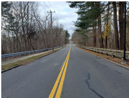
Vista de la parte superior de la presa en Armory Street con árboles que requieren eliminación a lo largo de las laderas de la presa
